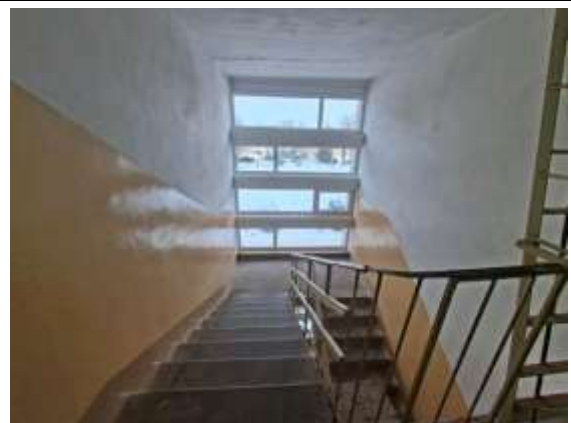
3.stāva kāpņu telpa
